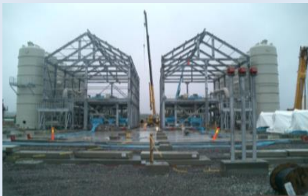
Petrochemia Kollsnes, Norwegia 300 ton konstrukcji stalowych
