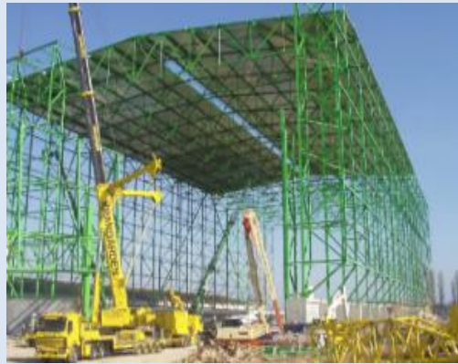
Hala, Dania, 1 750 ton konstrukcji stalowych
