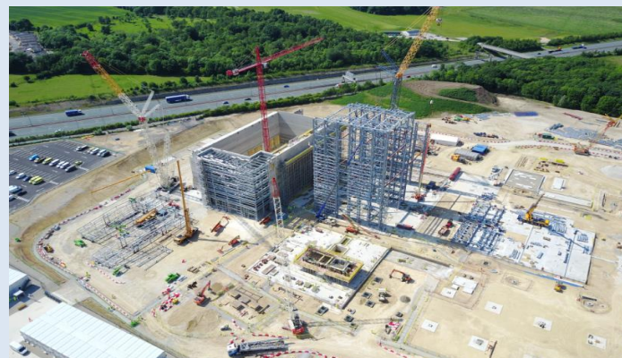
Spalarnia śmieci Ferrybridge, Wielka Brytania 6 500 ton konstrukcji stalowych
