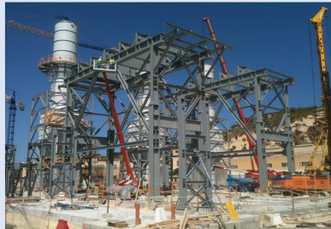
Konstrukcja wsporcza kotła Allborg, Malta 759 ton konstrukcji stalowych
