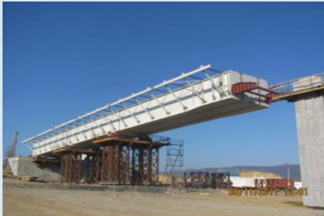
Most M14, Bielsko Biała – Żywiec, 3 682 ton konstrukcji stalowych
