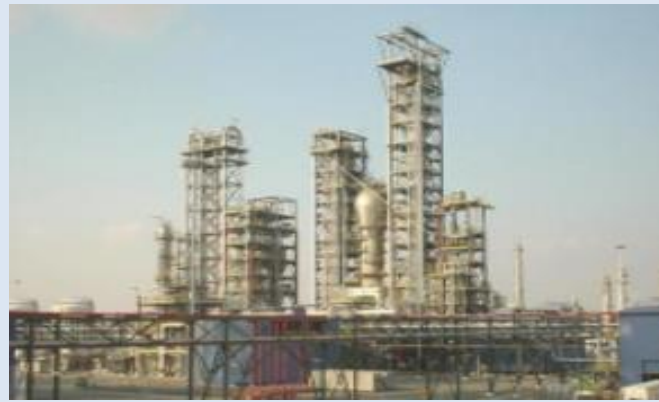
Petrochemia Libia, Afryka 600 ton konstrukcji stalowych
