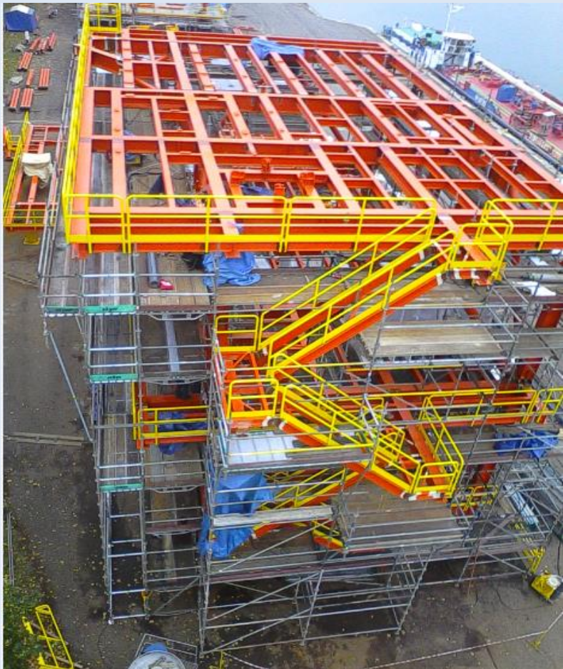
Wieża wiertnicza Lotos, Gdańsk 339 ton konstrukcji stalowych
