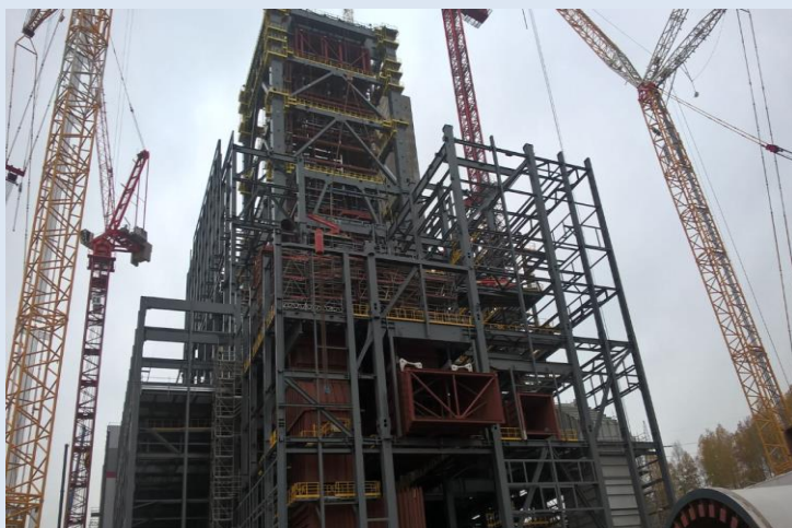
Elektrownia Turów, Polska 7 000 ton konstrukcji stalowych
