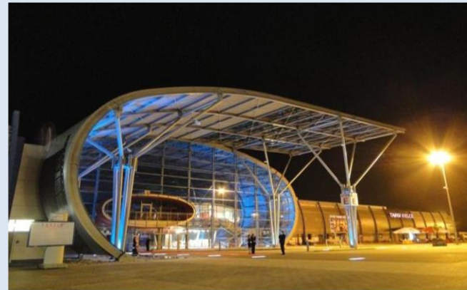
Centrum Targowe, Kielce 930 ton konstrukcji stalowych
