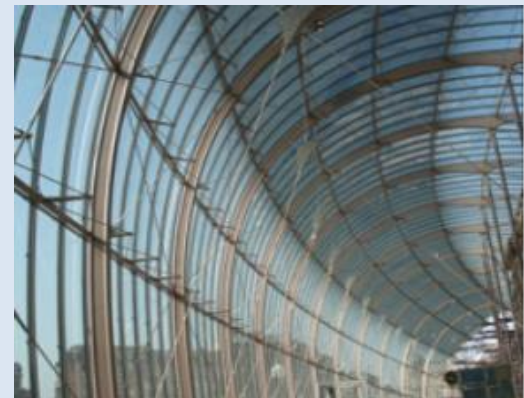
Konstrukcja fasadowa Dworca Kolejowego w Strasburgu 400 ton konstrukcji stalowych
