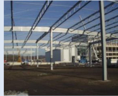
Hall Baglan, Wielka Brytania, 2 300 ton konstrukcji stalowych
