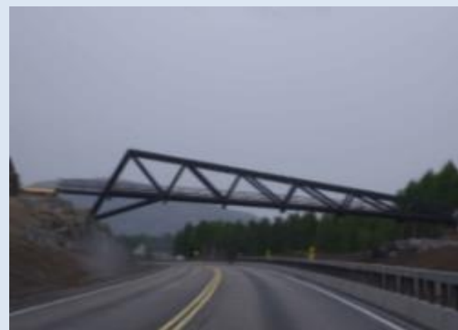
Most na odcinku autostrady E6, Norwegia 140 ton konstrukcji stalowych
