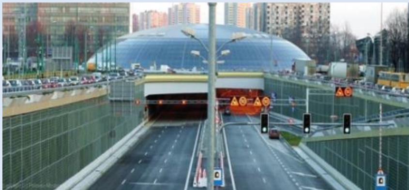
Konstrukcja stalowa kopuły nad rondem, Katowice, 240 ton konstrukcji stalowych
