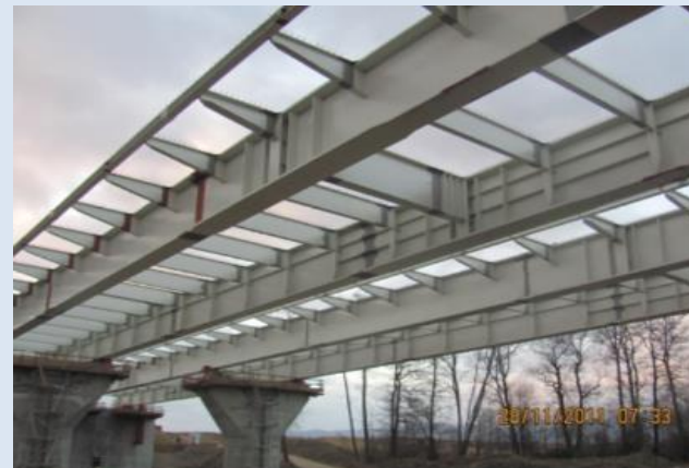
Wiadukt ES09 - S69, Żywiec - Bielsko Biała, 9 665 ton konstrukcji stalowych
