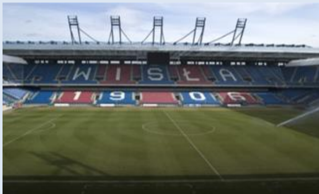
Stadion Wisły, Kraków 840 ton konstrukcji stalowych
