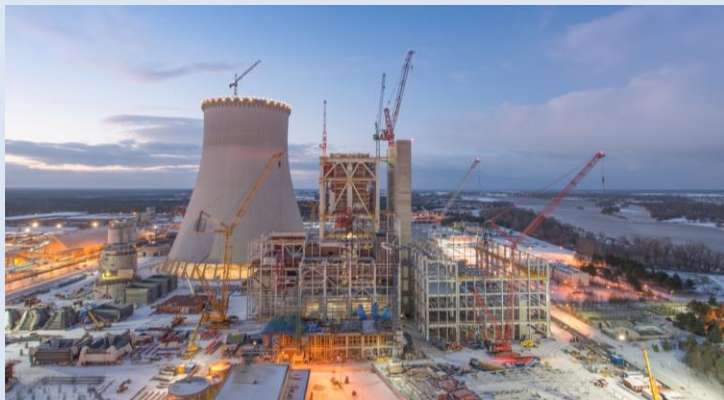
Elektrownia Kozienice, Polska 16 000 ton konstrukcji stalowych
