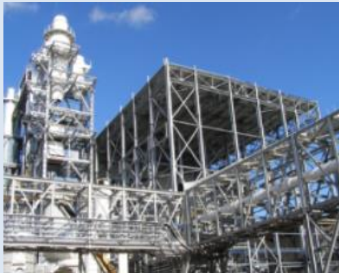
Zakład produkcyjny płyty HDF/MDF, Grajewo 1 750 ton konstrukcji stalowych
