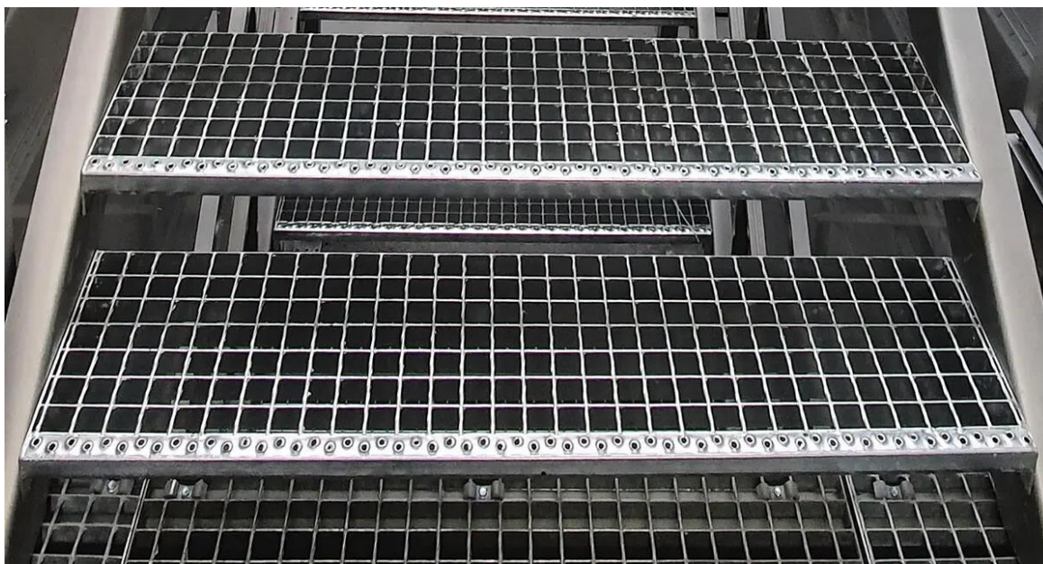
Rys.4 Sposób mocowania stopni schodowych.
